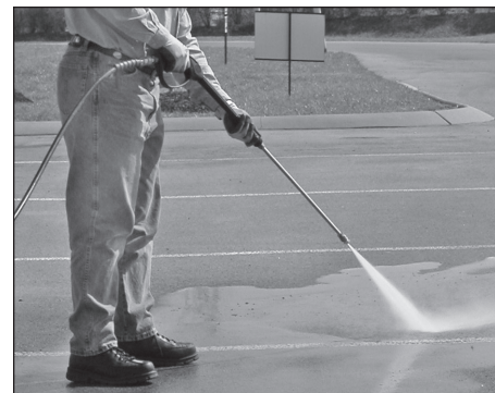
Figura 14 - Ángulo mejor para limpiar una superficie
