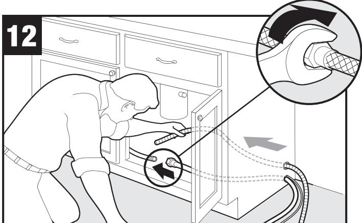
Attach waterline to hot water supply./Conecte la tubería de agua al suministro de agua caliente./Raccordez la canalisation d'eau à la canalisation d'approvisionnement de l'eau chaude.
