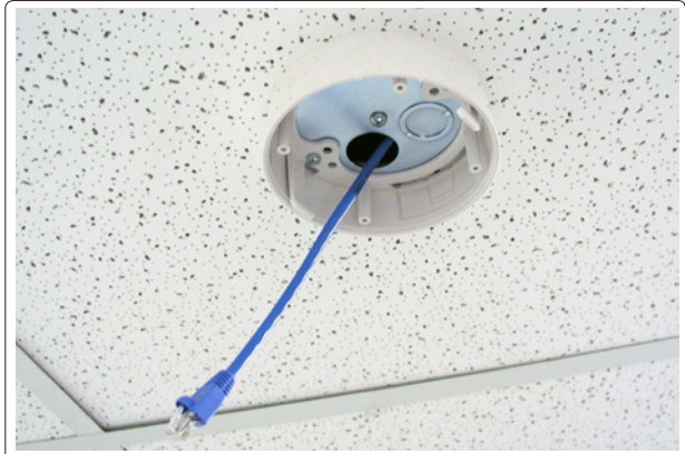
1a) Pull the cable(s).
