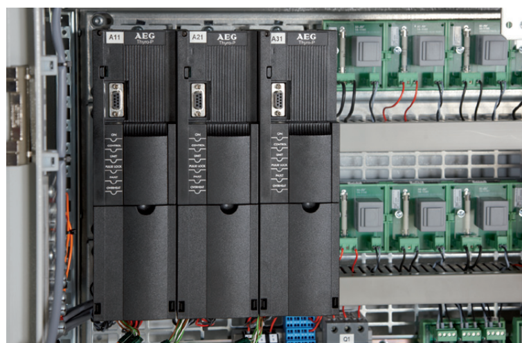
FIG. 7 CONTROL DEVICES THYRO-P A11, A21, A31
