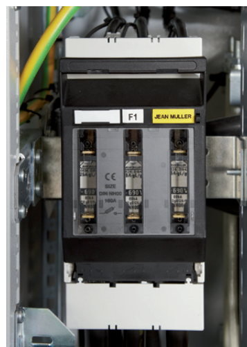
FIG. 4 FUSE LOAD SWITCH F1
