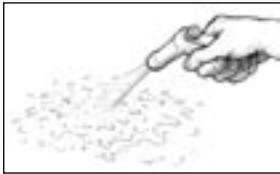
Kuva 33 Huuhtelee pinta puhtaalla vedellä hiomisen jälkeen.
