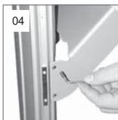
Druckerbord über das Beinprofil führen und in Gewindeschlitten mit je 2 Gewindestifte (Pos. 2) befestigen, Schrauben jedoch noch nicht festziehen!
