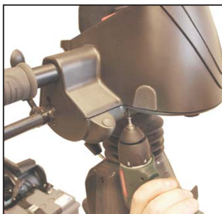
Montera av plastkåpan.
