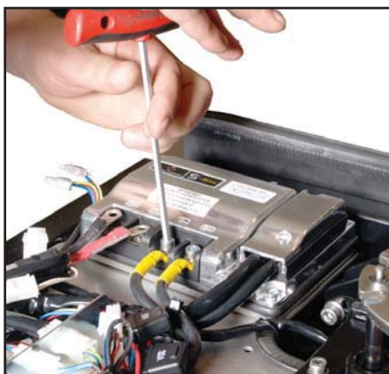
Montera av batterikablarna
