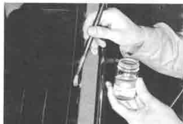
Fig. 14-8 Applying of primer
