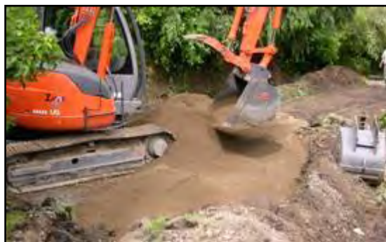
...and adding new compactable fill
