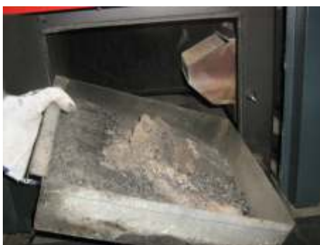
Enlever le cendrier, Le nettoyer, Le retourner dans des positions comme prévu
