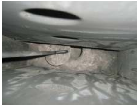
Enlever le couvercle du fond avec un crochet
