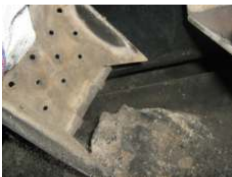
Renverser le contenu de la grille dans le cendrier et la retourner dans la position comme expliqué dans le manuel d'utilisation
