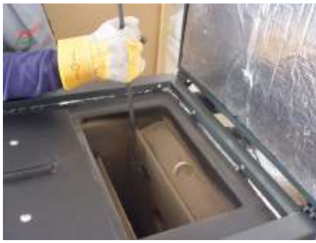
Nettoyer les surfaces de l'échangeur de chaleur en les grattant avec l'outil
