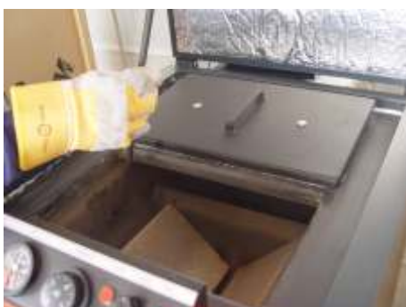
Nettoyer les surfaces de l'échangeur de chaleur en les grattant avec l'outil
