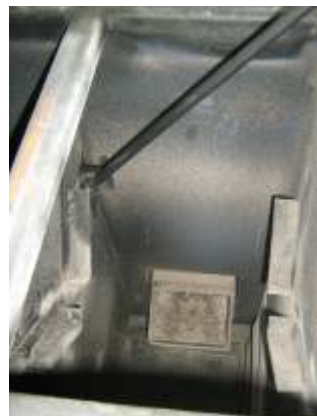
Nettoyer les surfaces de l'échangeur de chaleur en les grattant avec l'outil
