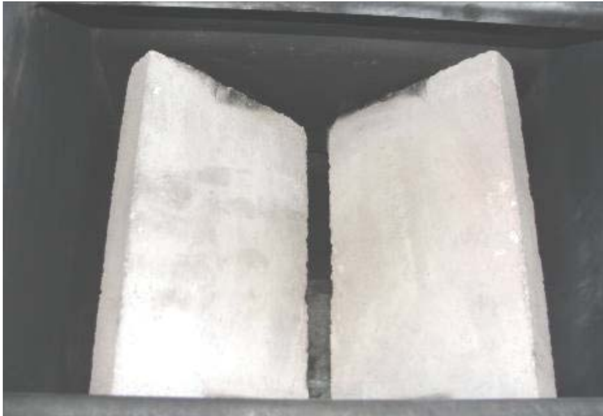
Figure 4.4. Les éléments céramiques sont installés dans la chambre de combustion de la chaudière à granulés de la série Pelletherm v4 (ils sont positionnés sur des plaques soudées de support spéciales)
