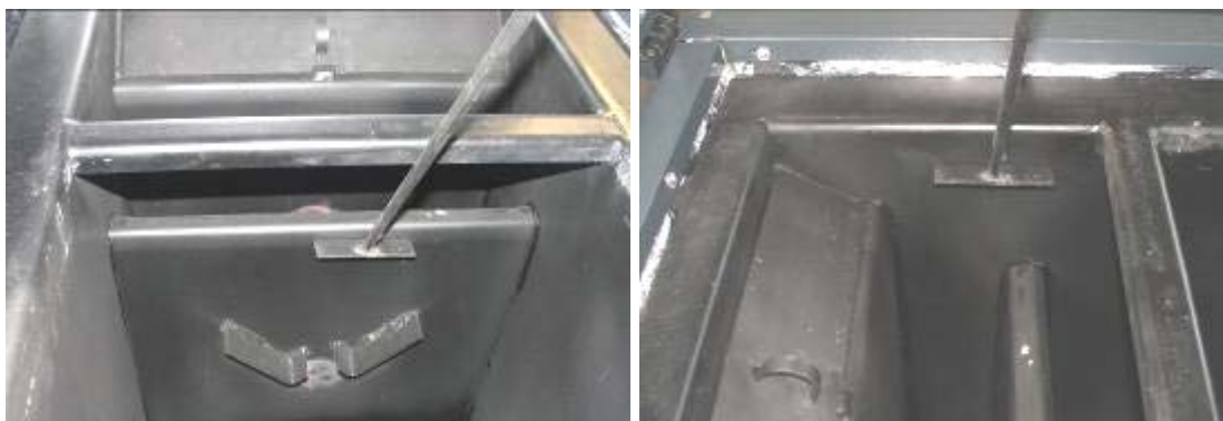
Figure 5.5 Grattage du résidu des cendres des surfaces de l'échangeur de chaleur de la chaudière à granulés de la série „Pelletherm v4”
