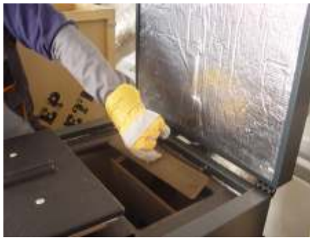
Nettoyer les surfaces de l'échangeur de chaleur en les grattant avec l'outil
