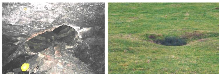
FIG. 1 – Exemple de formation d'un fontis au ciel d'une carrière (à gauche). Venue au jour (à droite).
