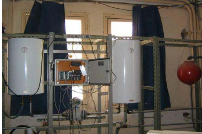
Fig. 4: Vue du banc d'essai-test réalisé à l'Université de Batna
