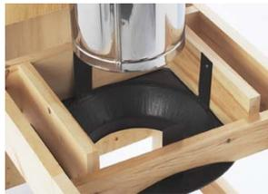
5- Ensuite, par en dessous du support, insérez l'adaptateur de tuyau de poêle et enclenchez en place en tournant.
