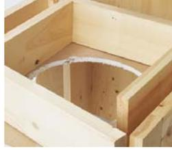
3- Pour installer le support de plafond, glissez l'ensemble dans l'ouverture du cadrage par le bas. Après vous être assuré que la plaque de finition est alignée avec la surface du plafond et que l'ensemble est au niveau, vissez le tout en place.
