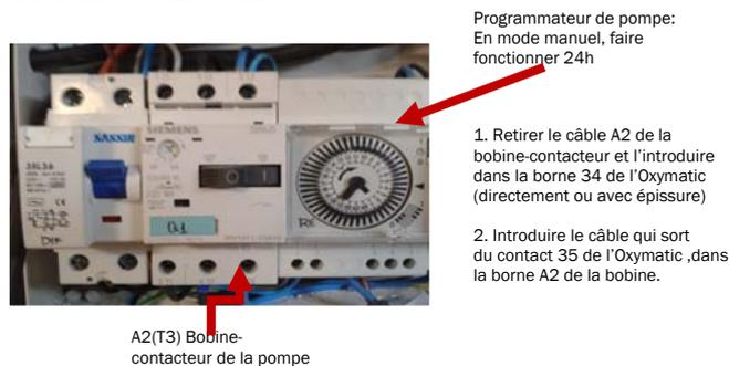
Dans les nouveaux tableaux électriques, nous n'aurons pas besoin du programmeur de pompe, puisque l'Oxymatic s'en charge.
