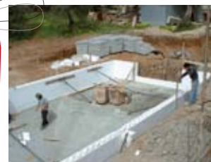
Montage des blocs
