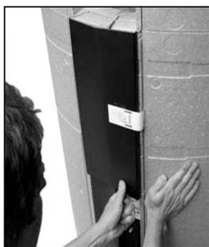
Sur le côté droit, faites sortir les profils de l'isolation mais laissez-les enfoncés sur le côté gauche.
