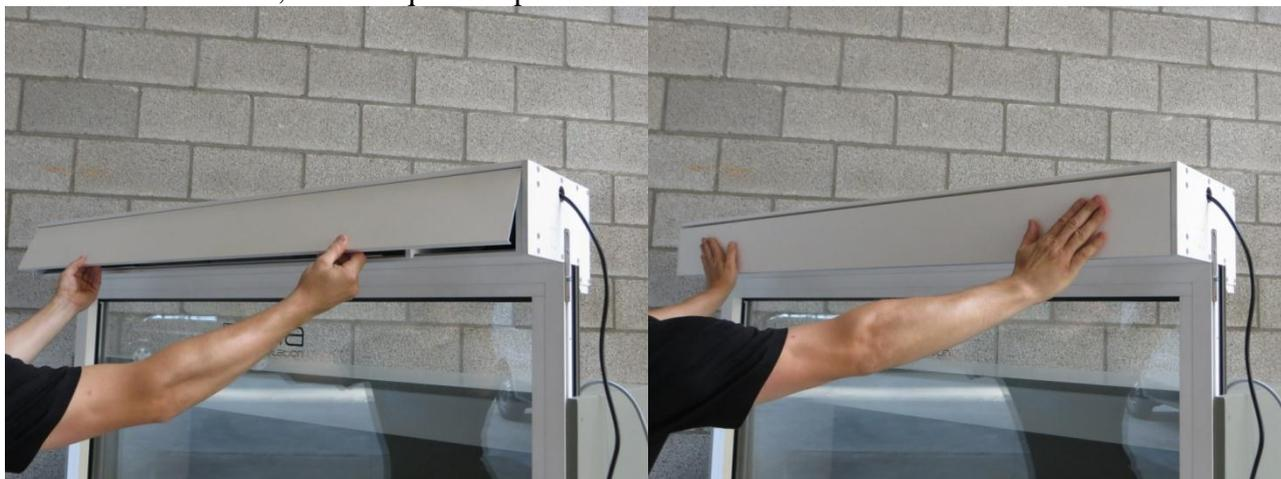
**Figure 12: Fermeture du capot**
