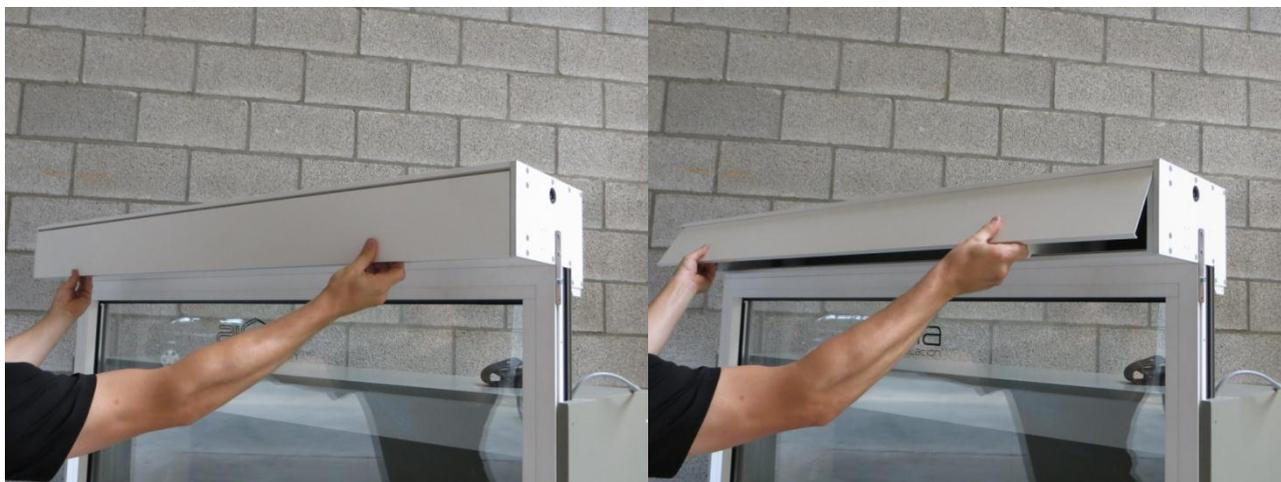
**Figure 1: Prise en main et détachement du capot**
