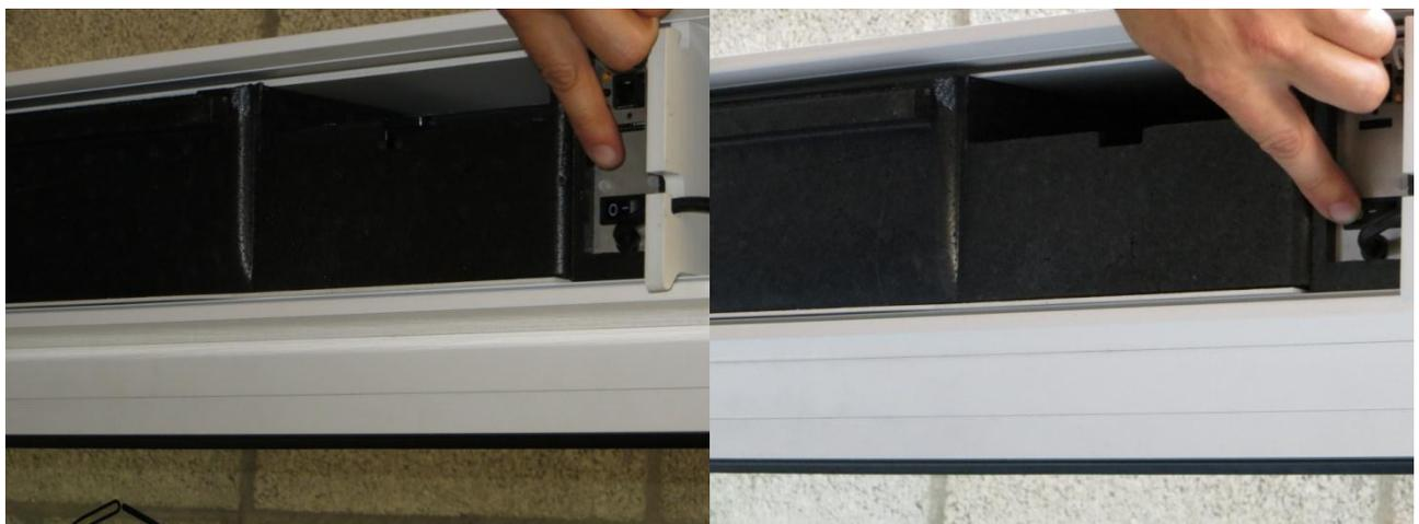
Figure 5: Interrupteur de l'UTA sur OFF
