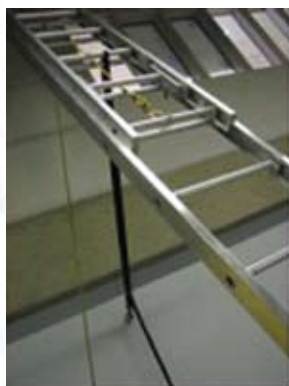
Figure H-9. Sangle d'ancrage fixée à un « piton » mural et retenant l'échelle au 10 e barreau.
