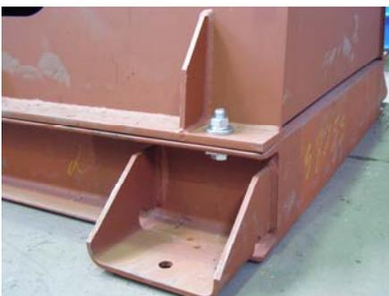
**Vue 9** : Exemple d'une fixation boulonnée de socle
