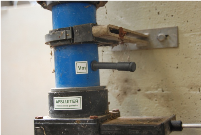
Gros plan sur Vm (point de test exact peut varier en raison de la législation nationale)
