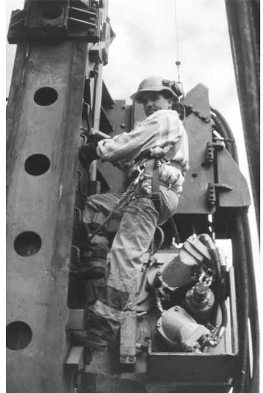
Fig. 1: la montée sur la jumelle se fait au moyen d'un dispositif de protection en hauteur.
