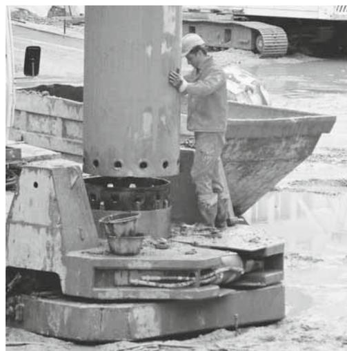
Fig. 3: l'assemblage des parties d'outillage s'avère particulièrement dangereux pour les mains et les pieds.
