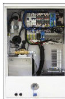
Système de courant de secours automatique intégré
