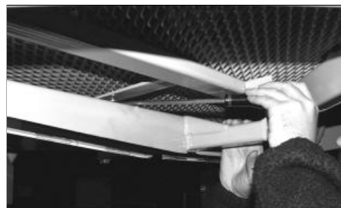
Fig. 5.1 - Test détecteur de surcharge.
