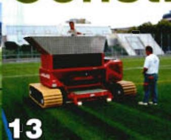
Deuxième remplissage au moyen de granulés de caoutchouc. Le type de caoutchouc ainsi que son épaisseur varient selon la destination du terrain.
