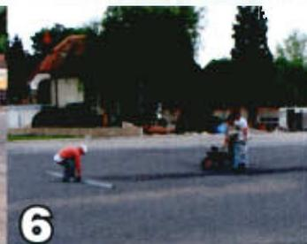
Contrôle et correction de la planie avant la pose du revêtement.
