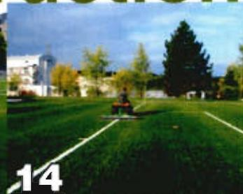
Brossage du gazon en phase de construction. Grâce à plusieurs cycles de brossage suivant un trajet prédéfini, les matériaux de remplissage sont répartis de façon régulière et en épaisseur constante.
