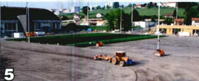
Réglage de la couche de support destinée à accueillir le gazon artificiel. Celle-ci peut être composée d'un enrobé bitumineux perméable ou de gravier dont la courbe permet une stabilité ainsi qu'une perméabilité indispensable au bon fonctionnement de la surface.
