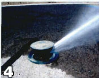
Test du système d'arrosage avant la pose de la couche de support. L'arrosage permet de gérer la température du revêtement lors de fortes chaleurs.
