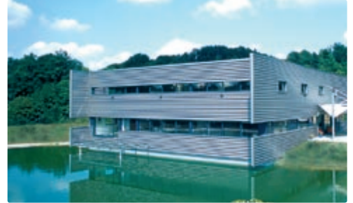
interscience Centre de R&D et pôle de production Mourjou FRANCE
