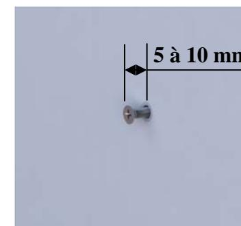
Approcher la vis de façon à laisser la tête dépasser de 5 à 10 mm du mur.
