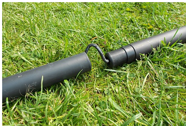
Figure 4.10: faites une boucle avec le câble avant assemblage
