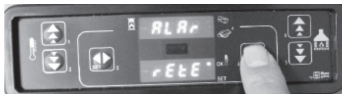
Figura 7: Indicazione del display dopo l'interruzione elettrica
