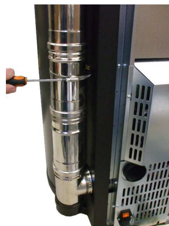
Fig. 59 - Collecteur des fumées (Sfera Plus, Sfera)
