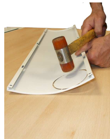
Fig. 25 - Ouvrir le trou (modèle Sfera Plus)
