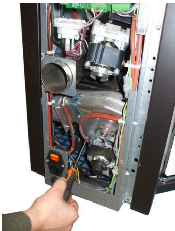
Fig. 60 - Nettoyage de l'aspirateur des fumées: phase 1
