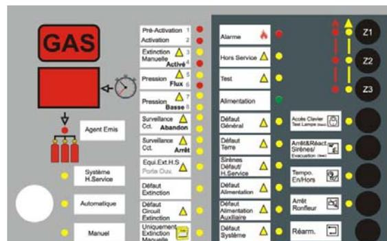
**NOTE:** Les sirènes ne pourront pas être arrêtées si le central est dans le processus d'extinction.
