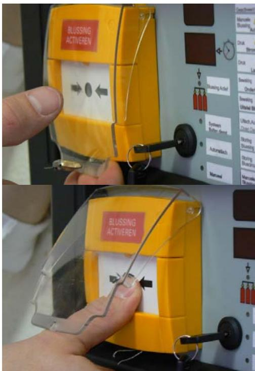
Le bouton poussoir d'extinction manuel intégré au central d'extinction doit toujours être muni de son scellé afin de répondre aux spécifications d'un bouton poussoir de type B. Ce scellé doit être remplacé après chaque utilisation.
