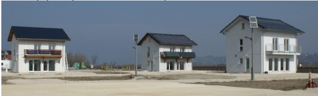
Figure 8 : Photo des trois premières maisons construites sur la plateforme INCAS
