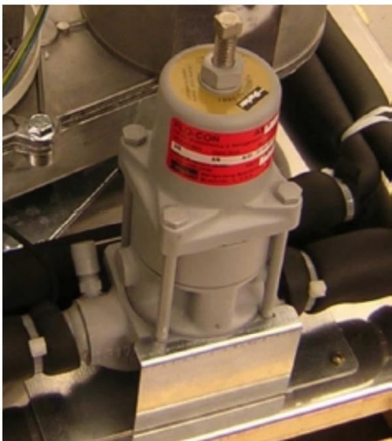
6 Soupape de sécurité haute pression réglée à 47 bar.
