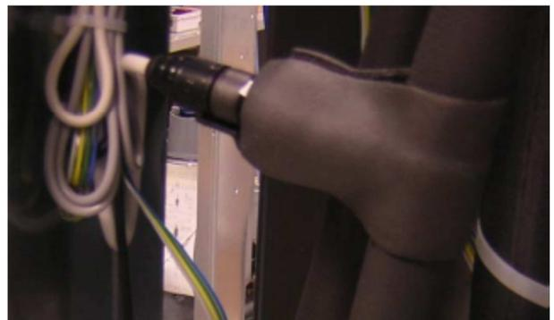
5 Vanne régulatrice de pression d'aspiration (Parker A8A) à régler à -20°C (18 bar)
