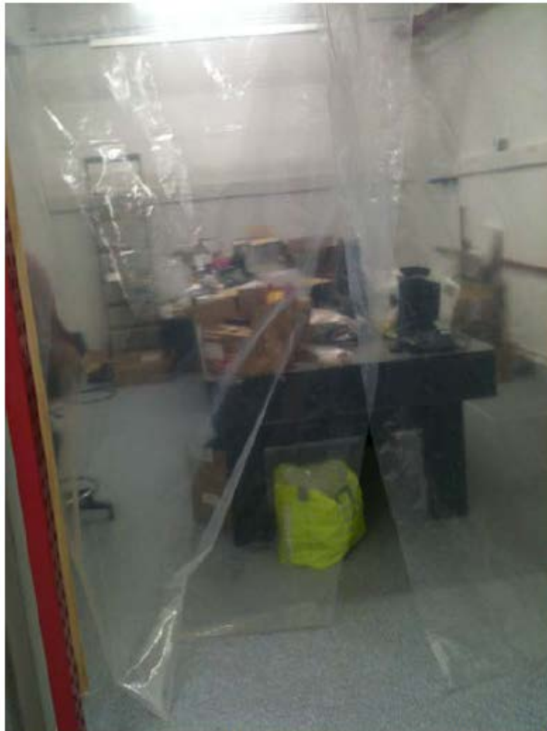
Pièce voisine - lasers en cours d'installation
