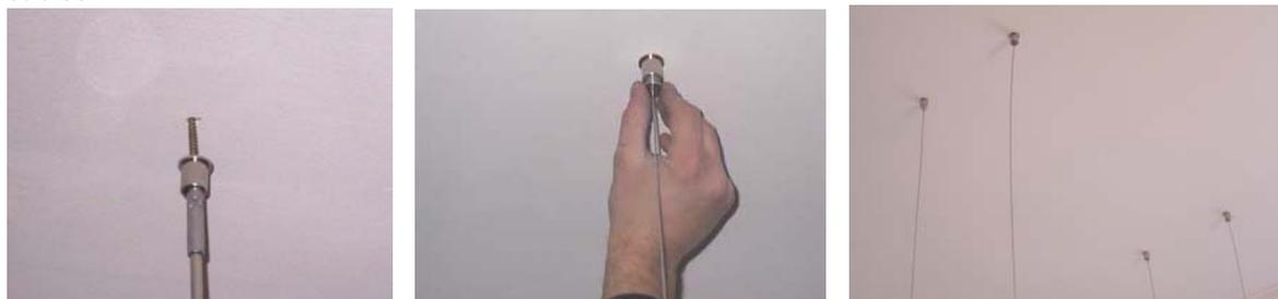
Une fois les câbles accrochés, placez LUXIMA sur les tréteaux et visser les 4 mécanismes autobloquants sur les parties déjà installées sur la plafonner. Dévissez les vis de sécurité Enfilez les câbles dans les systèmes autobloquants.
