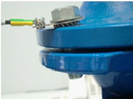
2. Placez la rondelle crantée de l'autre côté du boulon (sur le côté de la bride du compteur).
