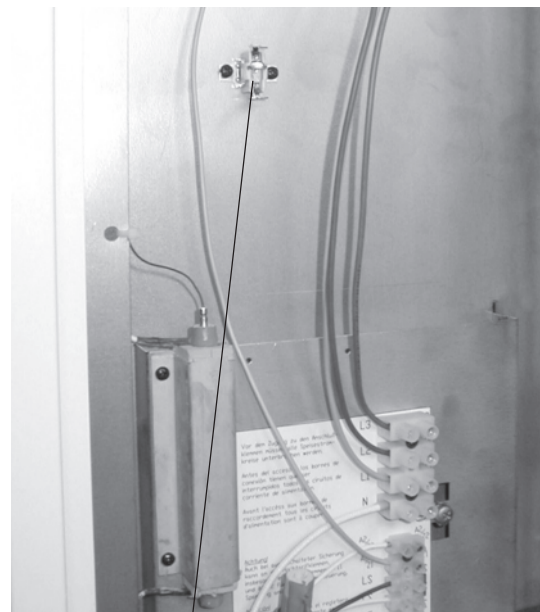
Fig.2 Thermostat de déclenchement 50 °C (F2.1)
