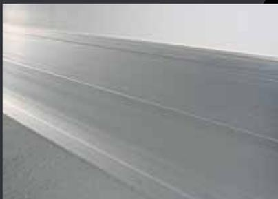
**Plinthes intérieures lisses encastrées dans le plancher,** d'une hauteur de 300 mm pour protéger les panneaux des agressions des chariots et des rolls.
