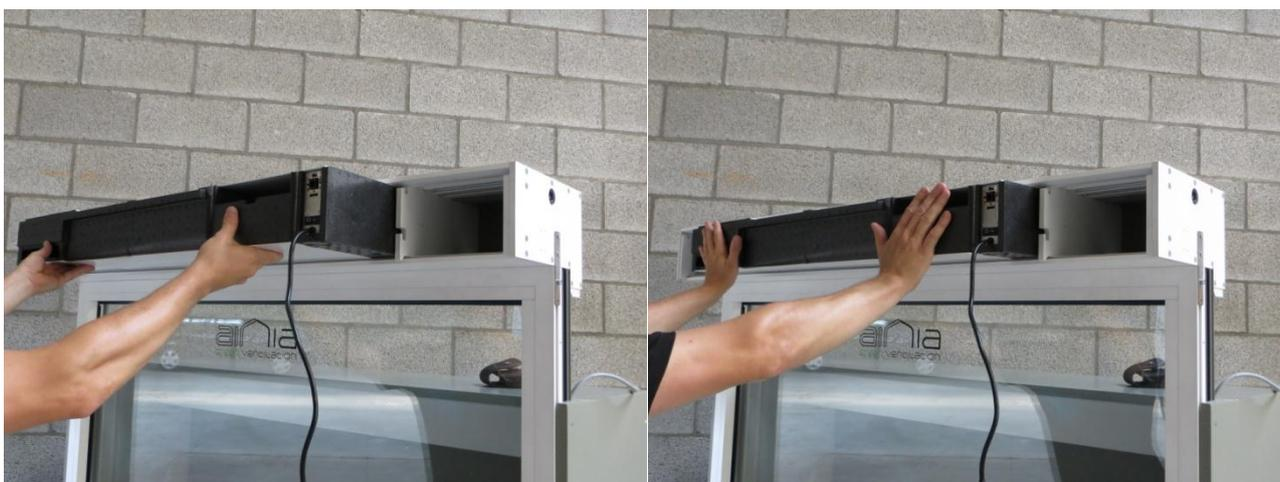
**Figure 7: Placement de l'UTA dans le boîtier**
