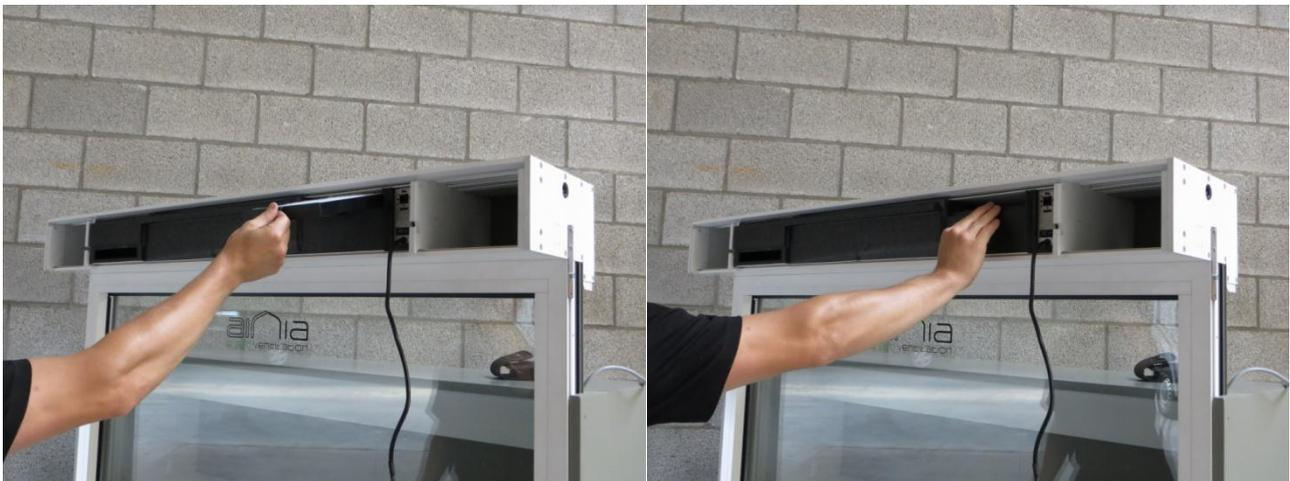
*Figure 10: Placement du filtre noir côté droit (côté vicié) de l'UTA*
