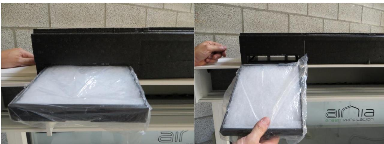
**Figure 6: Retrait des deux filtres de l'unité de traitement d'air**
