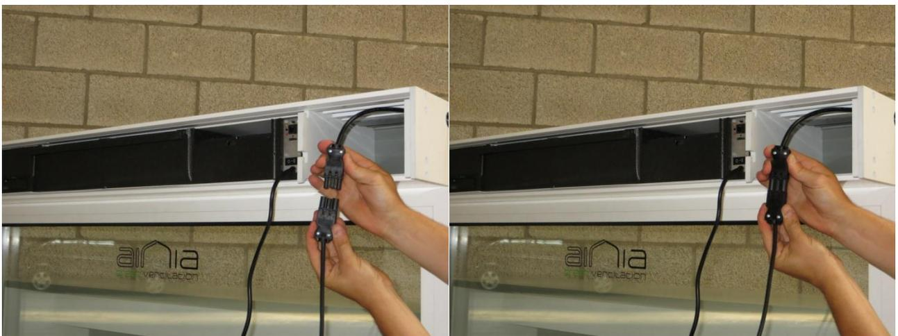
**Figure 12:** Branchement électrique de l'UTA
