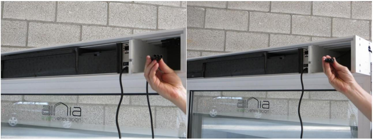
**Figure 11:** Prise électrique femelle provenant de l'UTA (gauche) et prise électrique mâle provenant du boîtier (droite).
