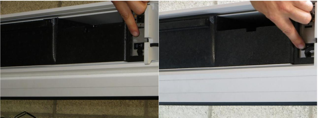
*Figure 4: Interrupteur de l'UTA sur OFF*
