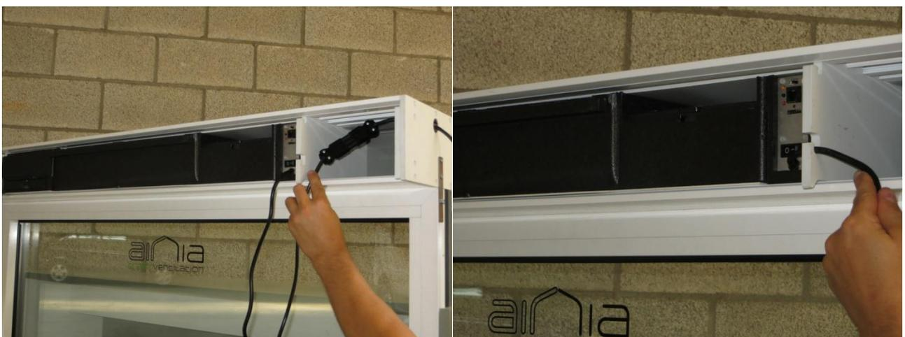
**Figure 13:** Rangement de la prise électrique et passement du câble à travers l'encoche.
