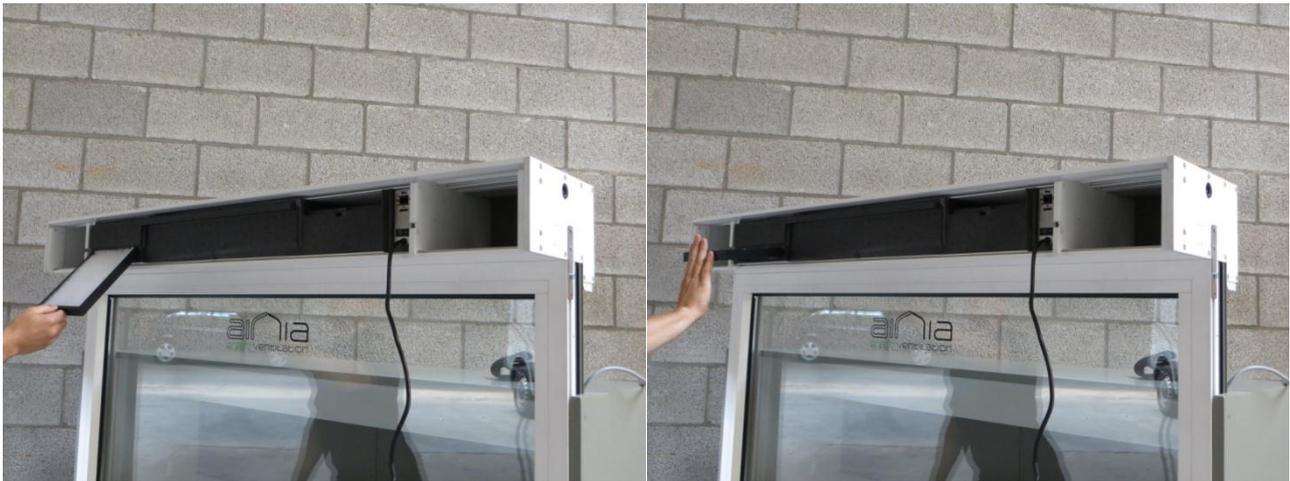
*Figure 9: Placement du filtre bleu côté gauche (côté frais) de l'UTA*
