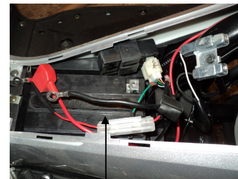
Emplacement de la batterie
