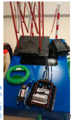
Vue du châssis trottoir avec regard de raccordement, boîtier d'adduction opérateur, pompe de test d'étanchéité, aiguille avec émerillon... (Dans FF12 déploiement horizontal)
