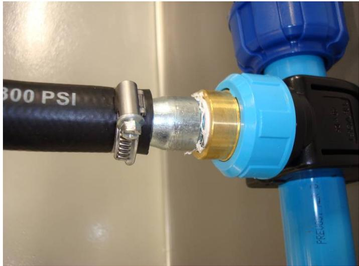
1" connexion pour réservoir à pression.
