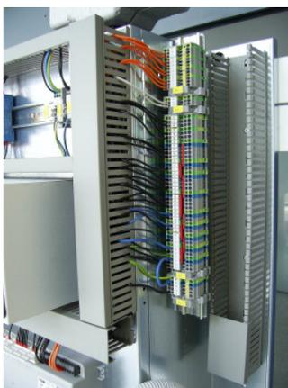
Elles se trouvent côté droit du socle. Fermer les composants externes et les sondes ainsi que le câble de connexion relié à l'unité extérieure selon les indications du schéma de branchement ci-joint. N'utiliser comme sonde extérieure que les types de sondes mentionnés dans le schéma de branchement. La puissance d'interruption du relai pour pompes de circulation externes s'élève à 2 ampères, max. 250 W inductif.
