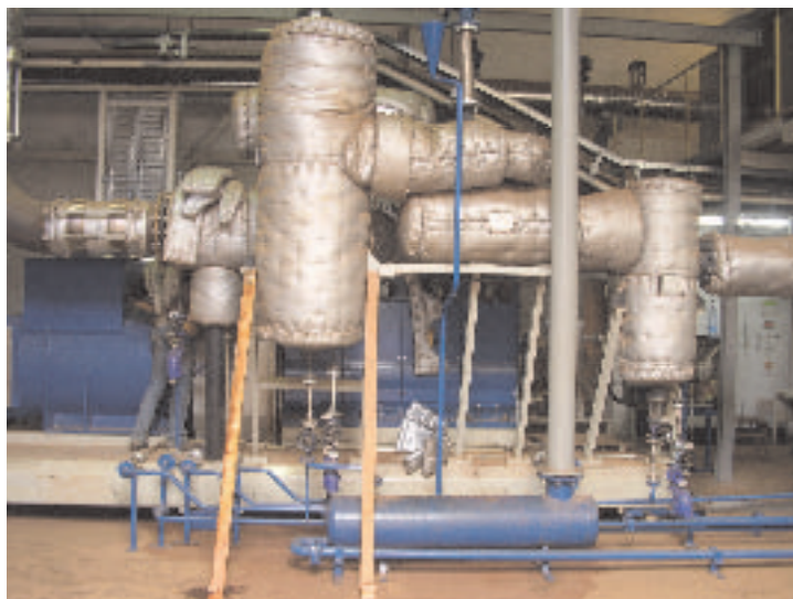
Moteur à vapeur installé pour générer de l'électricité © IFO
