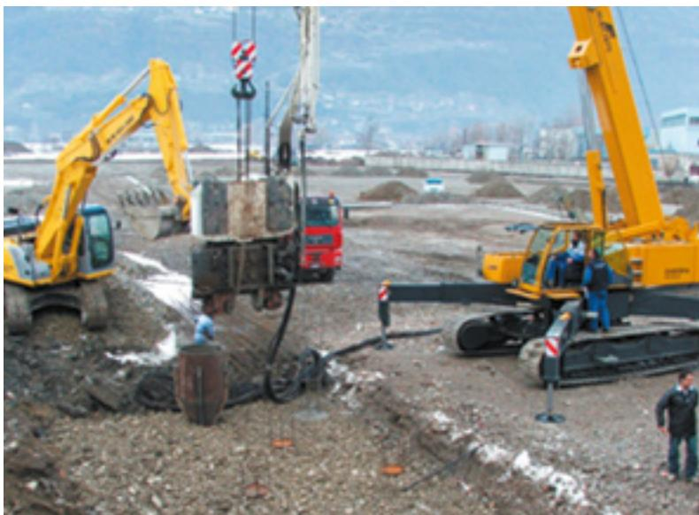
Molti cantieri necessitano di una preventiva azione di un bulldozer per far lavorare la gru su cingoli. La **SHERPA**, coi suoi stabilizzatori compensa eventuali dislivelli di terreno.
