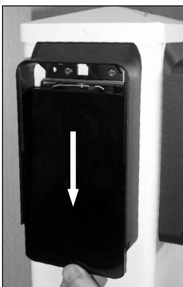
Figure 6 : démontage des vitres
