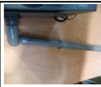
Le générateur doit être raccordé à une évacuation d'eau en PVC. Cette évacuation doit être de diamètre 40mm et avec une pente de 1cm/m pour une évacuation horizontale (voir photo). Pour une évacuation droite (pas comme sur la photo) utiliser un siphon sur la colonne descendante.
