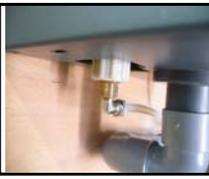
Le tuyau d'eau fourni avec le générateur doit être raccordé sur le réseau d'eau non adouci.
