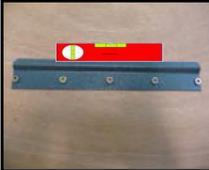
Remettre la réglette devant les trous et commencer à visser légèrement les vis dans les chevilles. Ensuite remettre le niveau à bulle sur la réglette pour vérifier la bonne mise à niveau de celle-ci. Puis finir le serrage.
