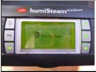
Le masque utilisateur apparaît. Faire défiler à l'aide des flèches jusqu'à 'entretien' puis appuyer sur 'ENTREER'. Descendre avec les flèches jusqu'au menu 'entretien hardware' Appuyer sur 'ENTREER'
