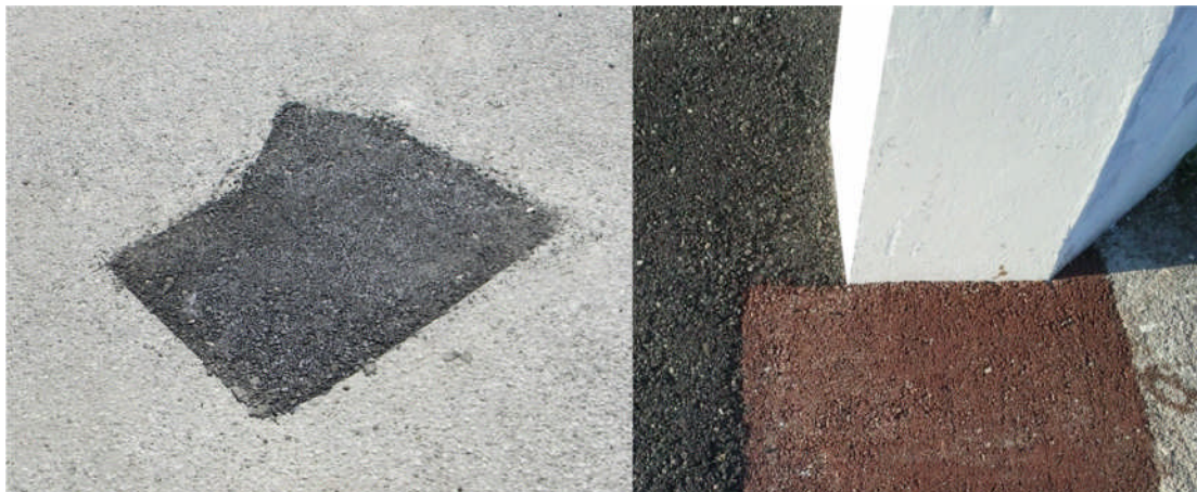
Nids-de-poule refaits avec la nouvelle méthode développée.
