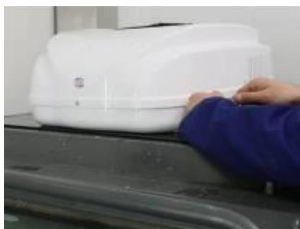
2. Placer le climatiseur SKIMO sur le toit puis le fixer par l'intérieur de la cabine avec les 4 vis M8 et leurs rondelles enlevées dans l'opération de préparation du SKIMO
