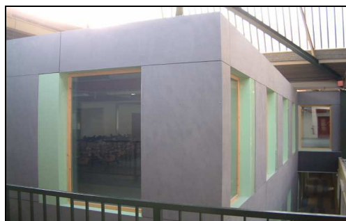
Figure 25. Un aperçu du bâtiment PREDIS
