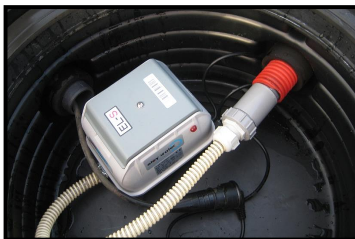
Figure 7-11: Raccordement électrique en local technique pour l'Oxyfix 21EH
